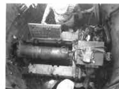
推進工 泥土圧 (M.13~M.12)
