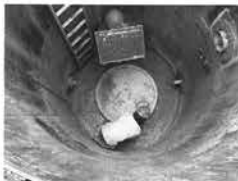
マンホール工 (M.13)
